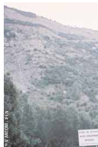
Glissement de terrain dans les Alpes-Maritimes
