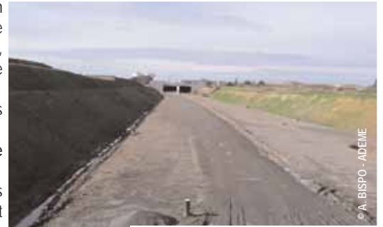
Imperméabilisation (construction d'une autoroute)
